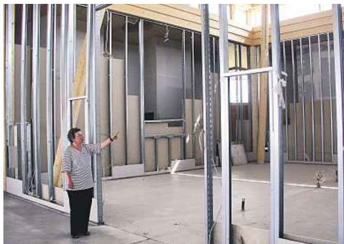
Pfarrerin Dr. Mayer-Schärtel inspiziert den Innenausbau.
