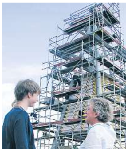
Maximilian Krauss und Pfarrerin Dr. Bärbel Mayer-Schärtel verfolgen den Bau des Glockenturms.
